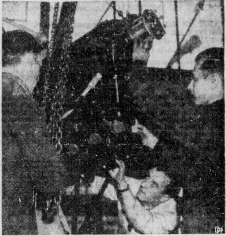
Ces mécanos de l'Aviation remplacent le moteur d'un avion de Haviland, qui sert à l'entraînement des pilotes. Les mécaniciens, ces "rampants", sont des auxiliaires précieux des équipages. Photo du Service de l'Information.
