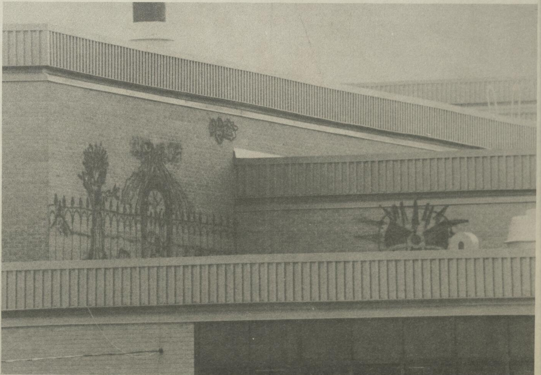
Sans doute au cours de l'été qui s'achève, la Polyvalente Le Bois de Victoriaville a été la cible de vandales. Comme l'indique cette photo, la partie supérieure du bâtiment a sans doute servi de toile à un peintre en herbe. (Photo René Houde)
