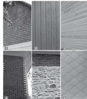
1. Revêtement de bardou de bois. 2. Revêtement de bois posé à la verticale. 3. Revêtement de bois posé à l'horizontal. 4. Revêtement de brique d'argile. 5. Revêtement en pierre. 6. Revêtement de bardou d'amiante hexagonal.
