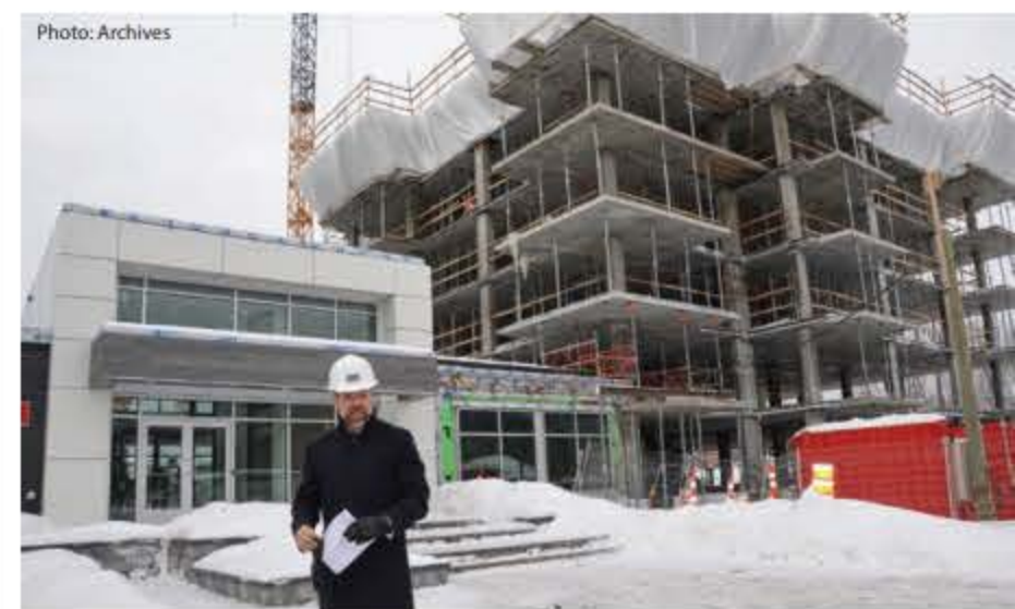
Le projet Station 7 est un bel exemple de développement dans le centre-ville de Saint-Jérôme.
