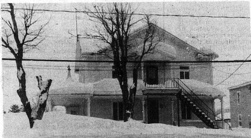
Cette maison au cachet invitant a été en partie détruite par les flammes d'un violent incendie qui a éclaté à cause d'une fuite dans un tuyau d'huile à fournaise.
