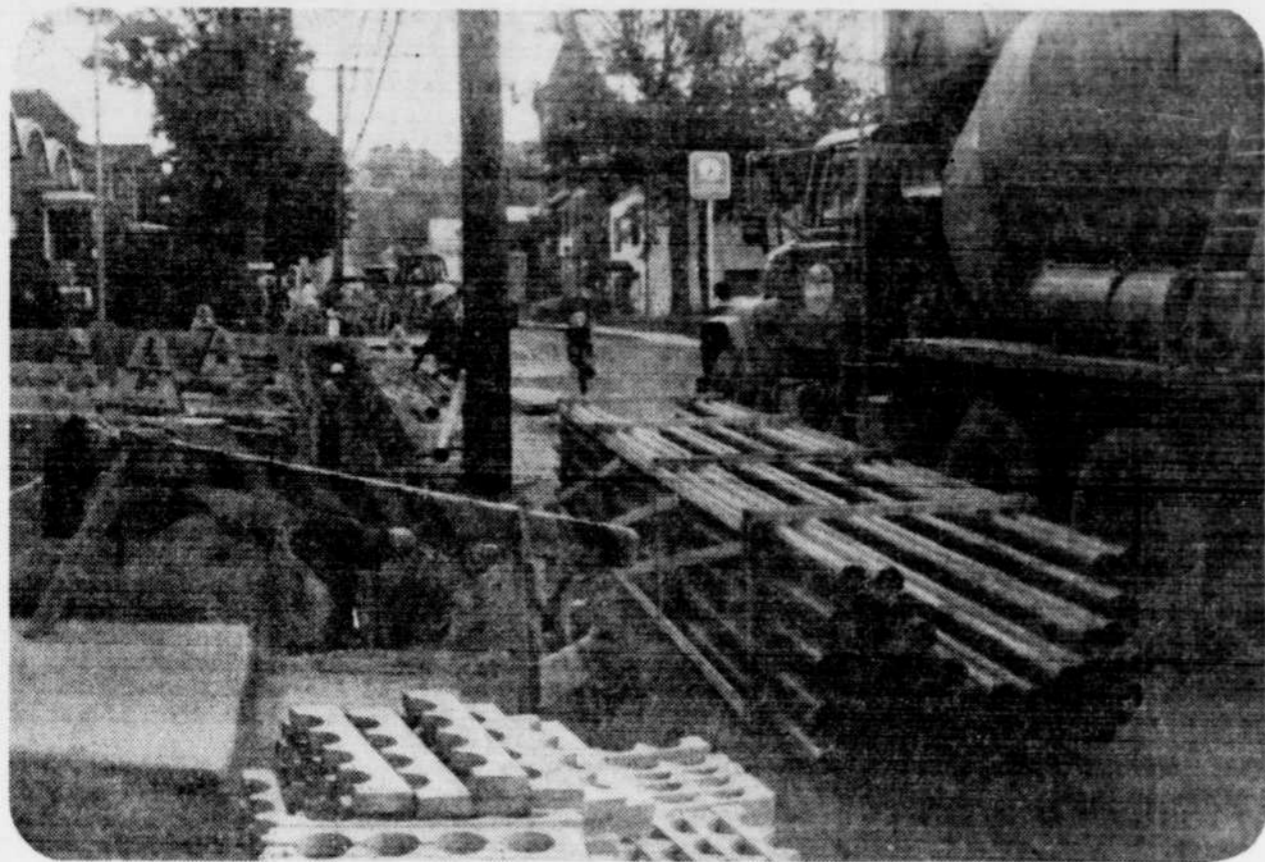
Les travaux d'agrandissement du central téléphonique de Témiscamingue, à Arthabaska, s'effectuent normalement et seront terminés comme prévu vers la fin de l'année. L'enfouissement de câbles fait aussi partie de ces travaux puis-
