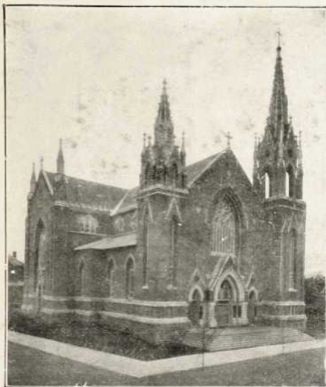
Cette église est COUVERTE avec nos BARDEAUX D'AMIANTE
