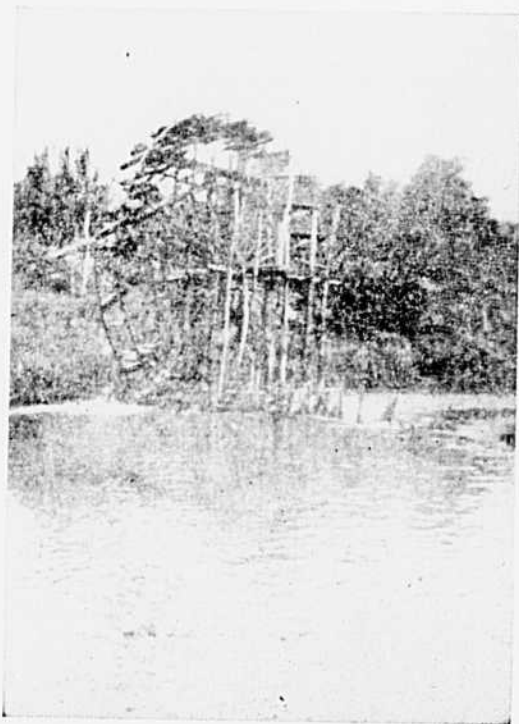
Figure 3. — Roue à eau chinoise en bambou Avec la bienveillante autorisation des éditeurs, cette figure est reproduite de l'ouvrage "Water Power Engineering" de H.K. Barrows, édité en 1934 par McGraw-Hill Book Co. Inc.
