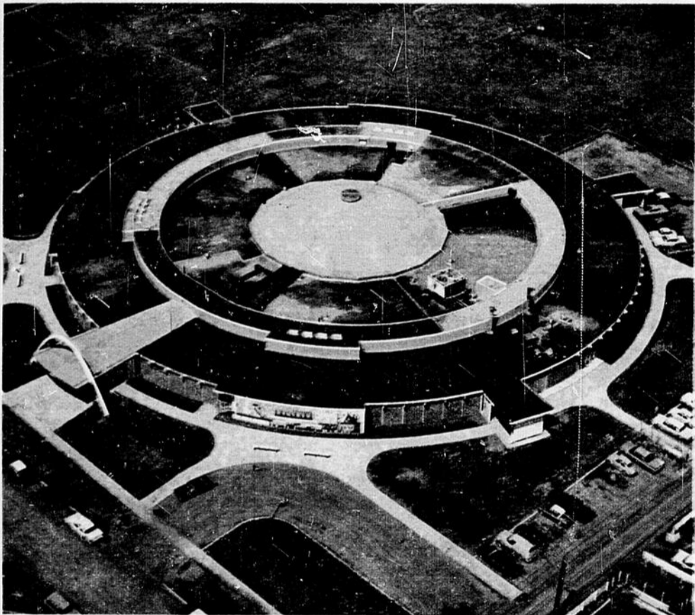
Vu d'un hélicoptère, Hillcrest High School, à Edmonton, apparaît comme un gigantesque anneau au centre duquel se trouve la salle du gymnase.
