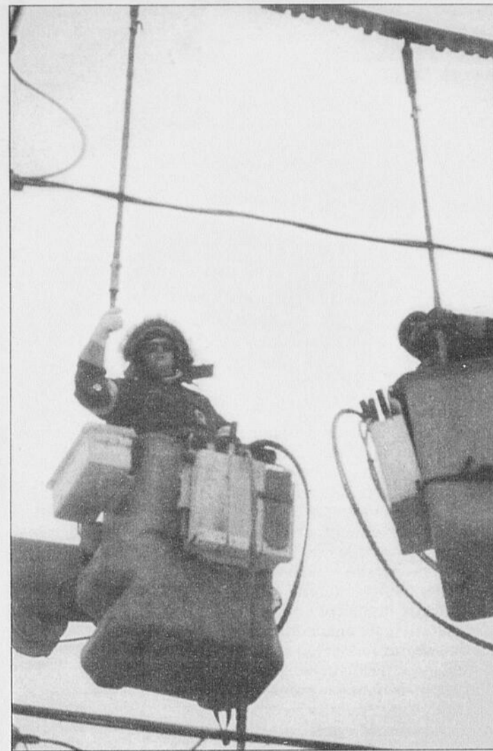
TRAVAIL - Les monteurs de lignes effectuent un travail dangereux. Daniel Gravel d'Alma, un monteur de ligne d'Énergie électrique Québec (Alcan) a été électrocuté alors qu'il exécutait une mission difficile en terrain accidenté avec les douze membres de son équipe, le samedi 23 janvier, à Saint-Bruno-de-Montarville.
