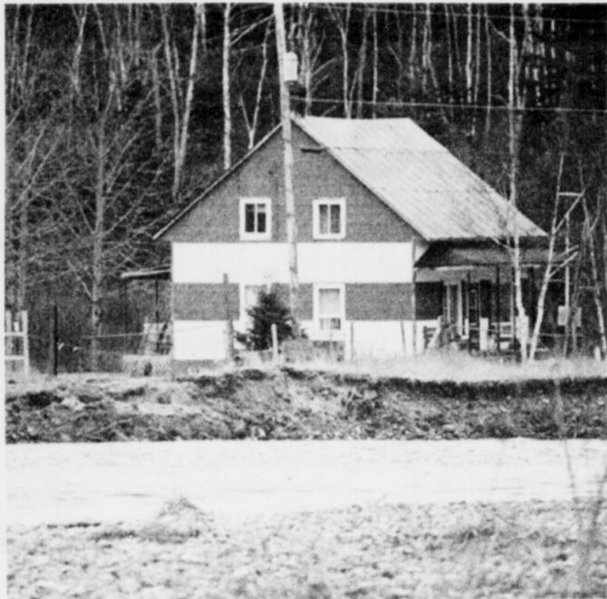
MENACEE - Cette maison près de la rivière St-Jean est menacée une autre fois par le gonflement des eaux.
