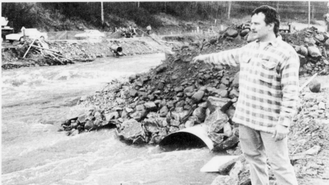
NOUS AVONS PEUR - Pierre Desgagné, un résident du 14, rue Du Portage de l'Anse-Saint-Jean qui a tout perdu lors du déluge de juillet 1996, affirme que les gens ont peur et qu'ils craignent les nouvelles pluies.
