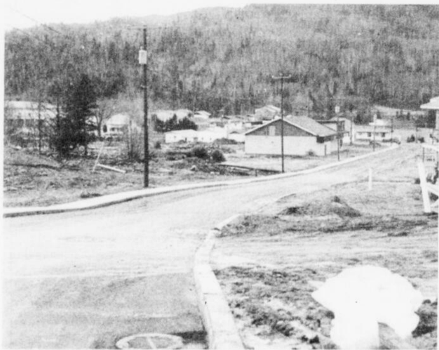
RETAPEE - La fameuse rue du Coin, rendue sens dessus dessous à la suite des inondations de juillet, a été remodelée. Hier, des employés de la voirie ont dû creuser une canalisation pour éviter d'autres dommages.
