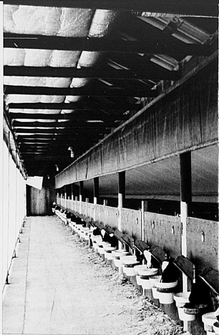
A) Le plan initial ne comportait pas de contre-toit. B) Aujourd'hui, on retrouve deux toiles pour couper le vent et pour conserver la chaleur au-dessus des veaux.
