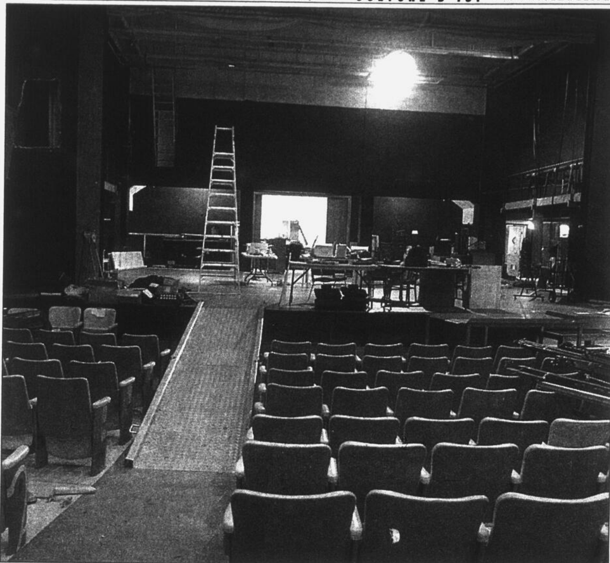
Bien que le projet de rénovation ne soit pas encore officiellement en voie de réalisation, au Théâtre des Deux Rives, on s'affaire déjà à préparer les lieux pour le début des travaux.
