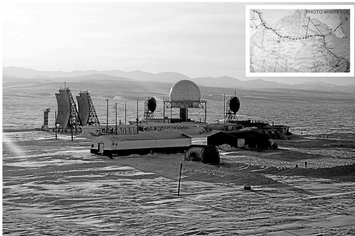
L'une des installations de la DEW Line. Ces radars sont les yeux des pilotes de CF-18 canadiens de Bagotville et Cold Lake lorsqu'un avion russe approche du Canada. En mortaise, la ligne DEW (zone d'alerte avancée) traverse le nord du Canada d'est en ouest de l'Alaska au Groenland pour éviter tout intrus venant de la Russie. — PHOTO GOOGLE 45 NORD
