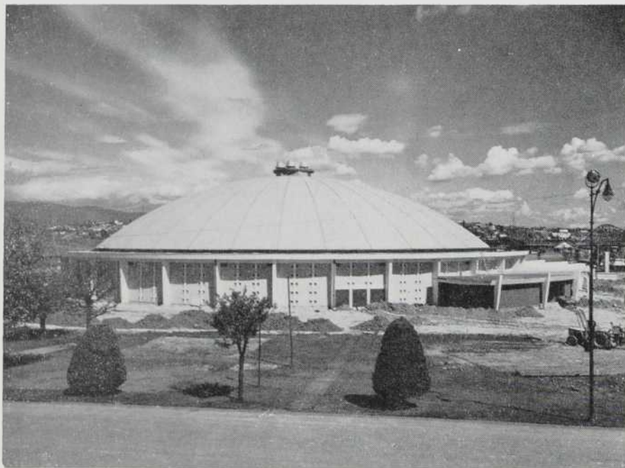
Tranchant sur le parc de l'Exposition nationale du Pacifique, à Vancouver, le nouvel "Agrodome" a une toiture en néoprène et en "Hypalon" deux caoutchoucs synthétiques.
