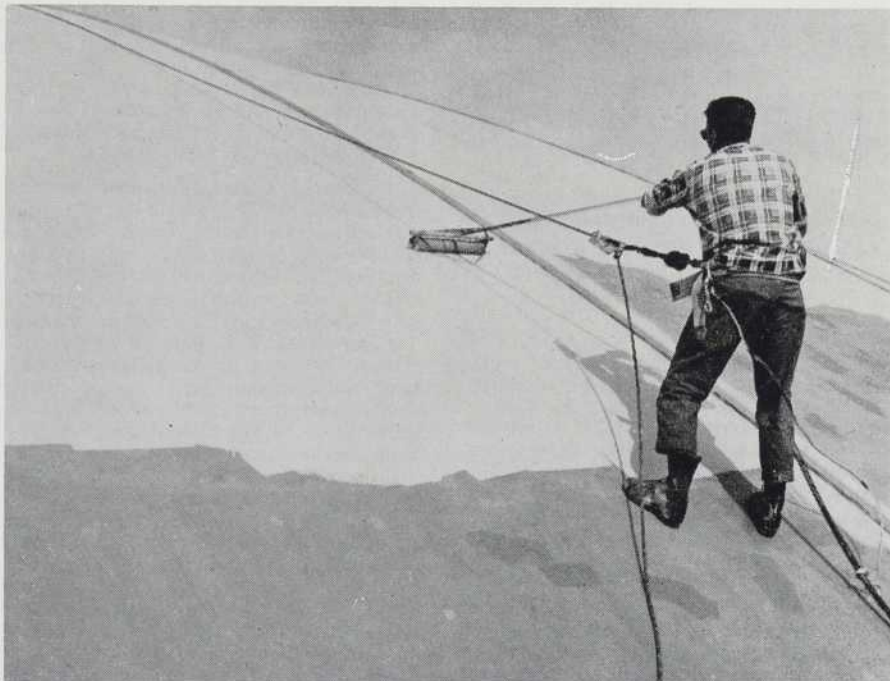
Un ouvrier applique au rouleau, la première des deux couches de deux millièmes et demi de pouce de "Hypalon" vert sur le néoprène noir.
