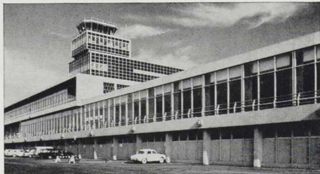
Installation de Twindow à l'aéroport internationale de Montréal, à Dorval.
