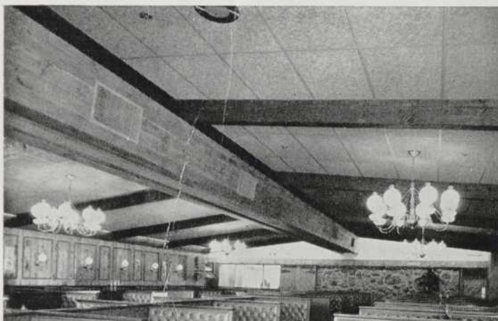
Swiss Chalet , B.B.Q. Panneaux acoustiques 24" x 48" Tectum de 1". Décorateurs : Winston Design Associates Ltd.
