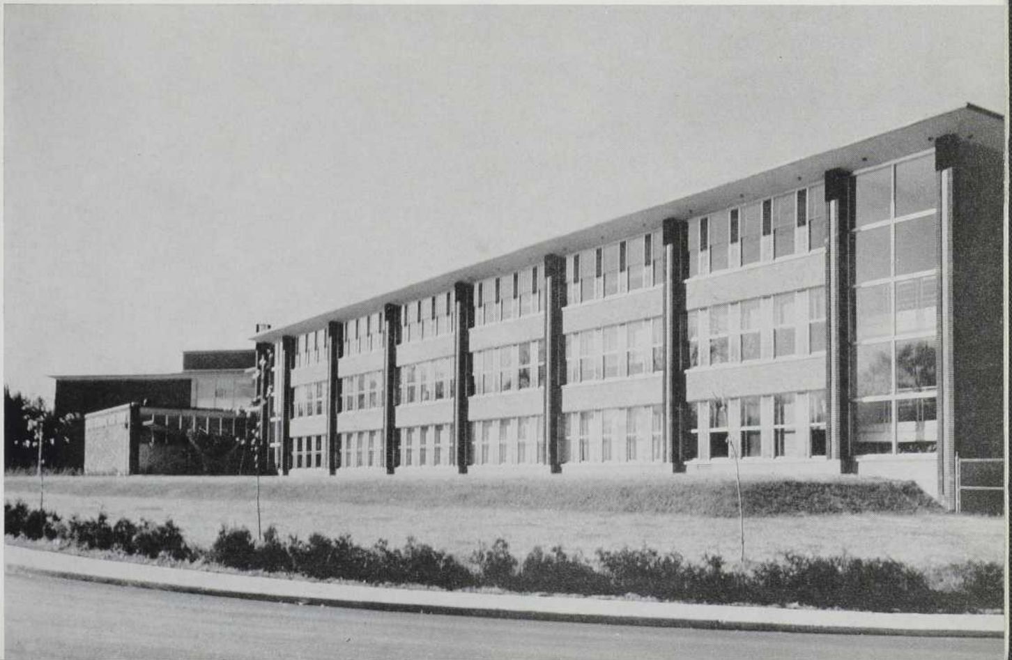
Vue d'ensemble de la façade principale, du côté du bloc des classes.
