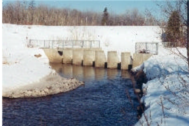
Figure 14 : Photographie de l'estacade de Duberger dans la Ville de Québec
