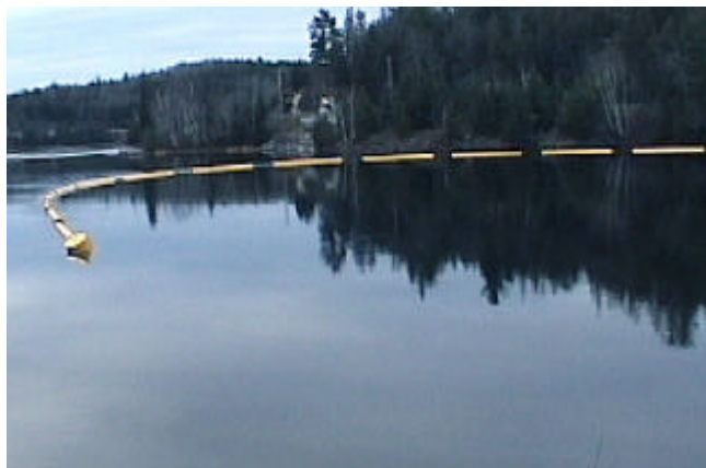
Figure 23 : Exemple d'estacade flottante (d'après Fleet Technology, Ottawa)
