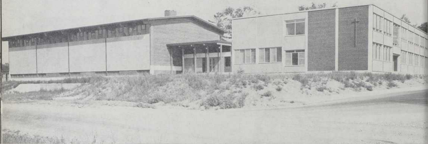
Vue d'ensemble du parc-école, montrant l'aile des classes, à droite et la salle de gymnastique, à gauche.
