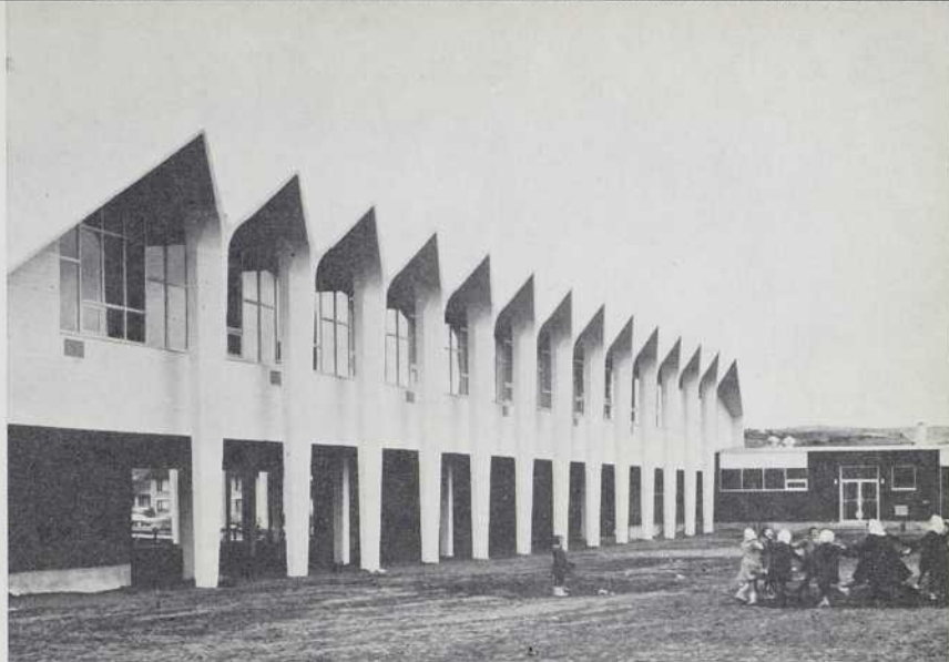
Perspective de façade, mettant en relief les colonnes indépendantes qui supportent la dalle plissée de béton de la toiture.
