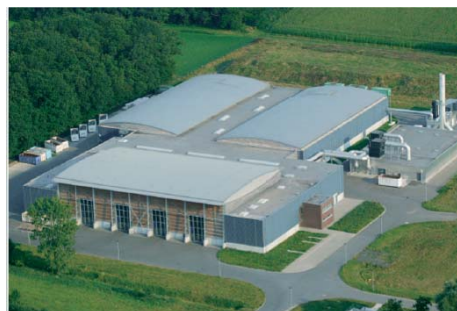
Figure 8 : Usine de biométhanisation (Linde, France)
