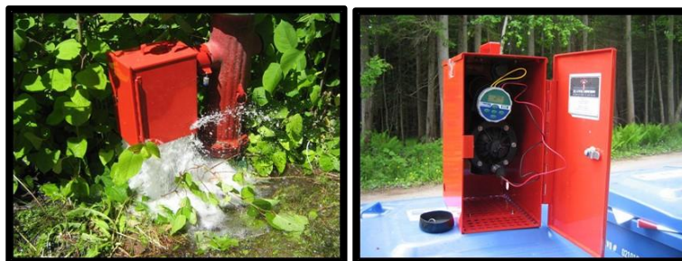
Figure 15. Purges programmables sur poteau d'incendie
