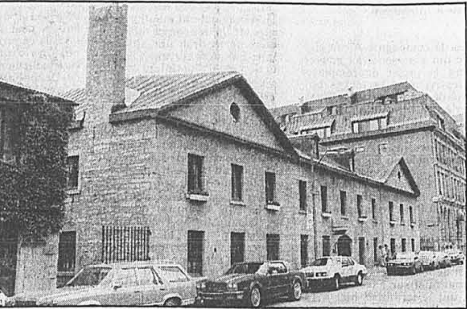
Les écuries et le bâtiment étroit recouvert de lierre, à gauche, ont été restaurés en 1967. À noter que la porte cochère est cintrée. PHOTO MICHEL GRAVEL, La Presse
