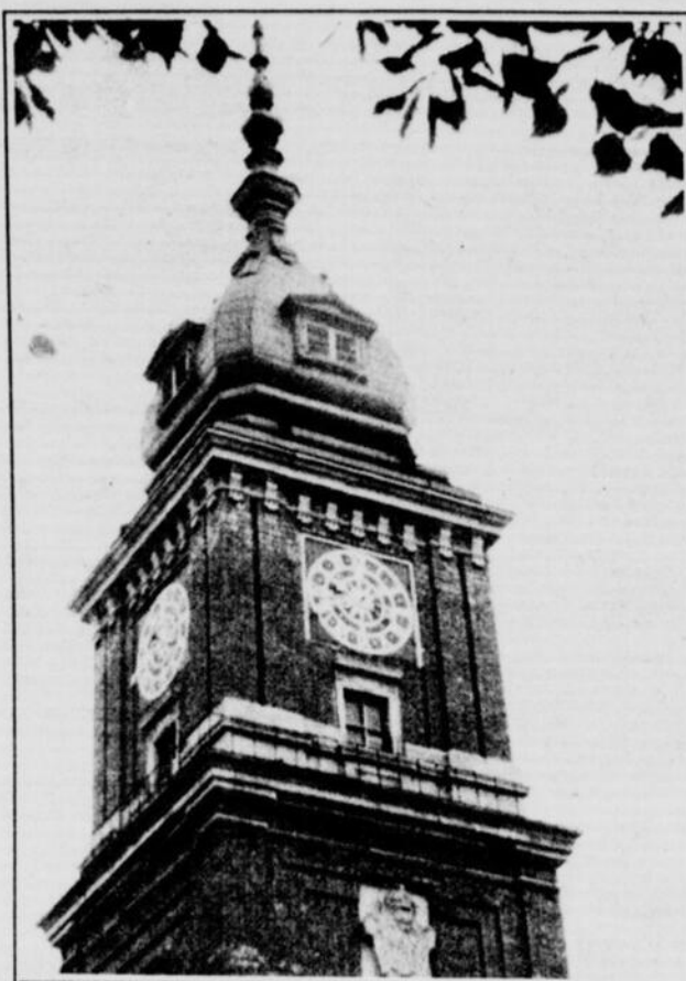
La tour de l'horloge du château royal de Varsovie est reconstruite ainsi que l'ensemble du palais dont il ne reste plus qu'à compléter le revêtement extérieur pour lui redonner son aspect de jadis.
