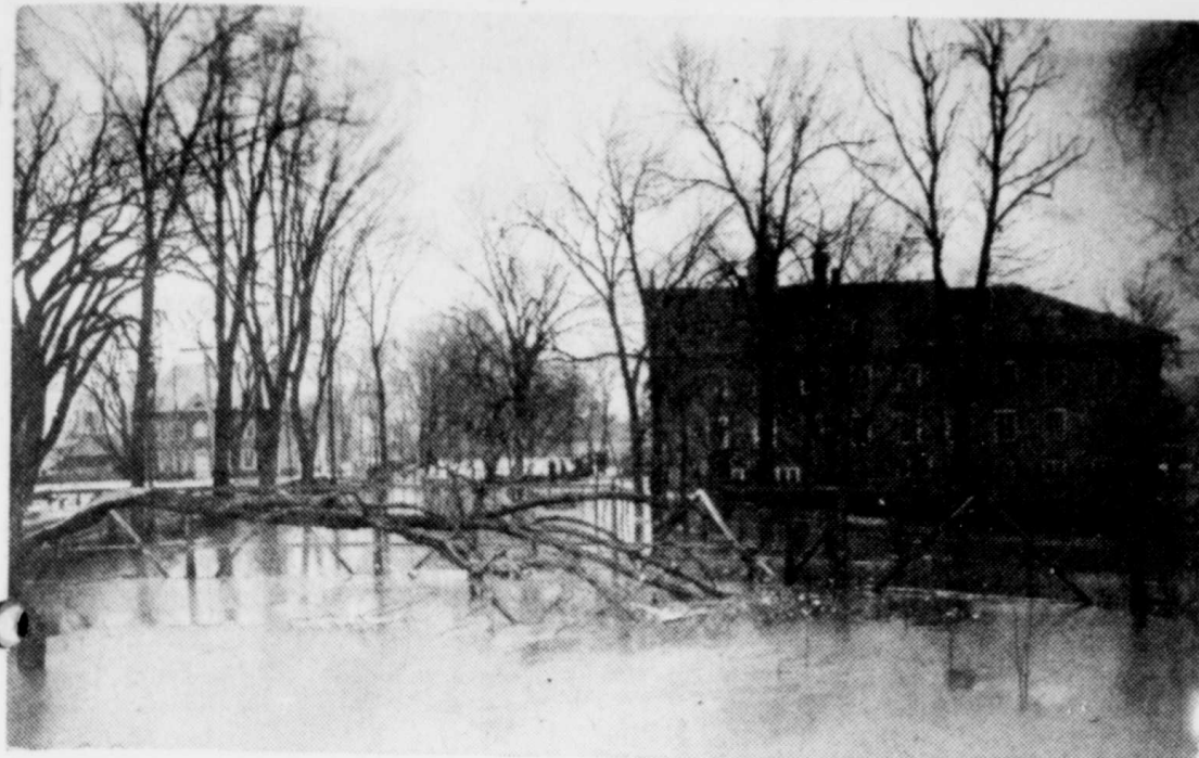
Une vue de côté du couvent des Soeurs de Jésus-Marie. A gauche à travers les arbres, on peut voir l'ancien Manoir de Longueuil, démolli peu de temps après l'inondation pour permettre l'élargissement de la rue St-Charles Est.
