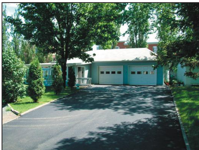
12. La maison d'été et le garage. 115P078.
