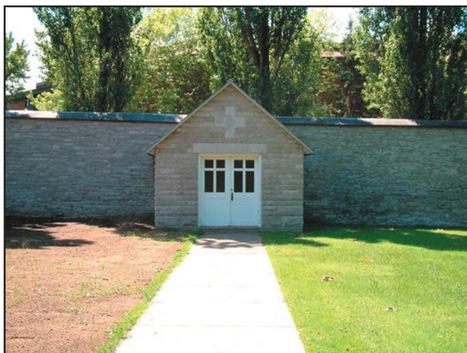
14. L'ancien charnier du cimetière servant maintenant de remise. 115P072.
