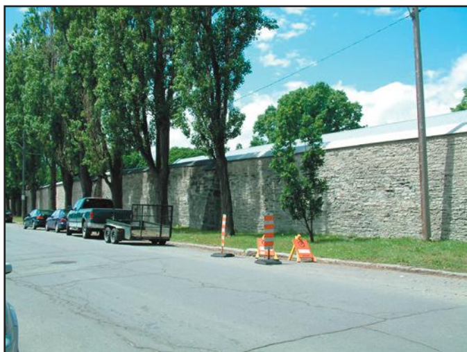
5. Le mur d'enceinte longeant la rue des Commissaires Ouest. 115P058.
