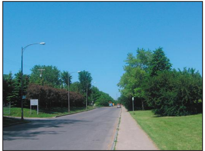
3. Absence de front bâti sur l'avenue Simon-Napoléon-Parent. À gauche, la propriété des Augustines. À droite, le parc Victoria. 115P026.
