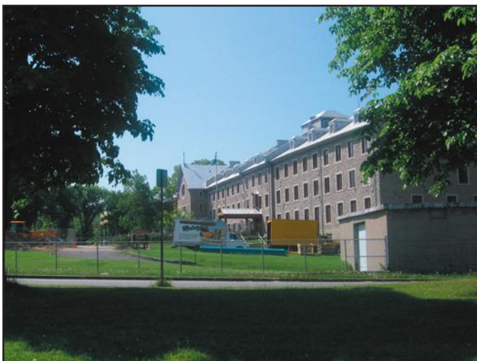
23. Clôture fermant l'accès du côté de l'avenue Simon-Napoléon-Parent. 115P033.
