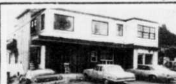
Immeuble, 4 logements, situé 34, rue Poirier, St-Jean-Eudes.
