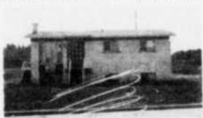
Split Level, avec logement au sous-sol, brique extérieure, situé au 454, de la Tamise, Jonquière, M.L.S.
