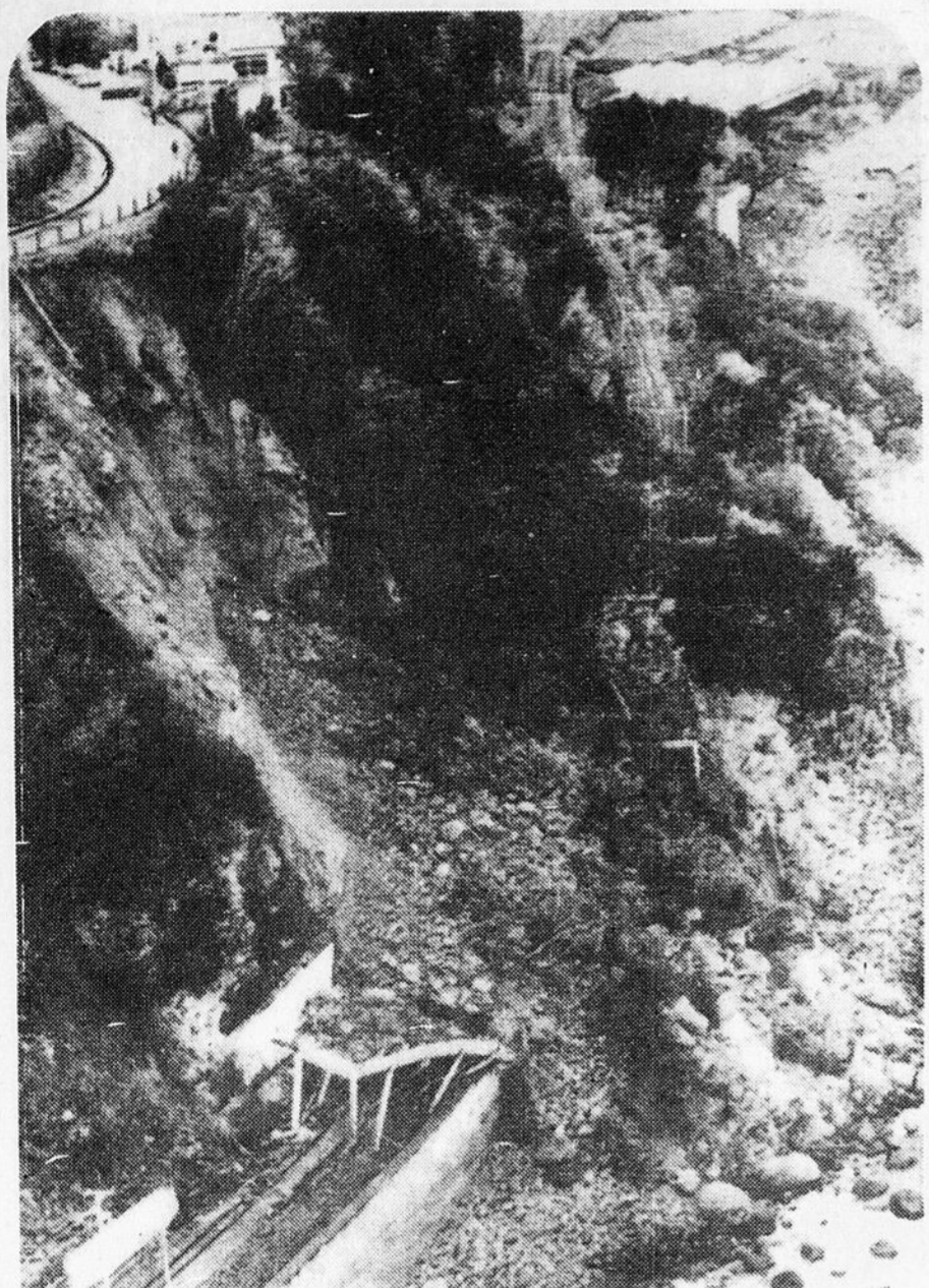
TUNNEL ECRASE — Un tunnel de protection en acier qui recouvrait la voie ferrée Izu Kyryke près de Higashi-Izu, au sud-est de Tokyo, a été écrasé samedi, après qu'un tremblement de terre destructeur eût secoué le Japon. Le glissement de terrain survvenu à cet endroit n'a laissé aucune chance au tunnel de protection. (Téléphoto PA)
