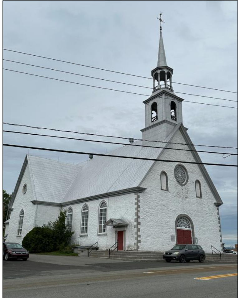
Église de Saint-Pierre-de-la-Rivière-du-Sud. (Photo : Véronique Bergeron)
