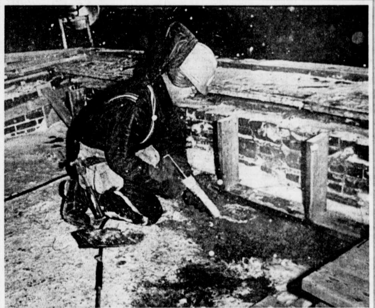
Les travaux se sont poursuivis toute la nuit
