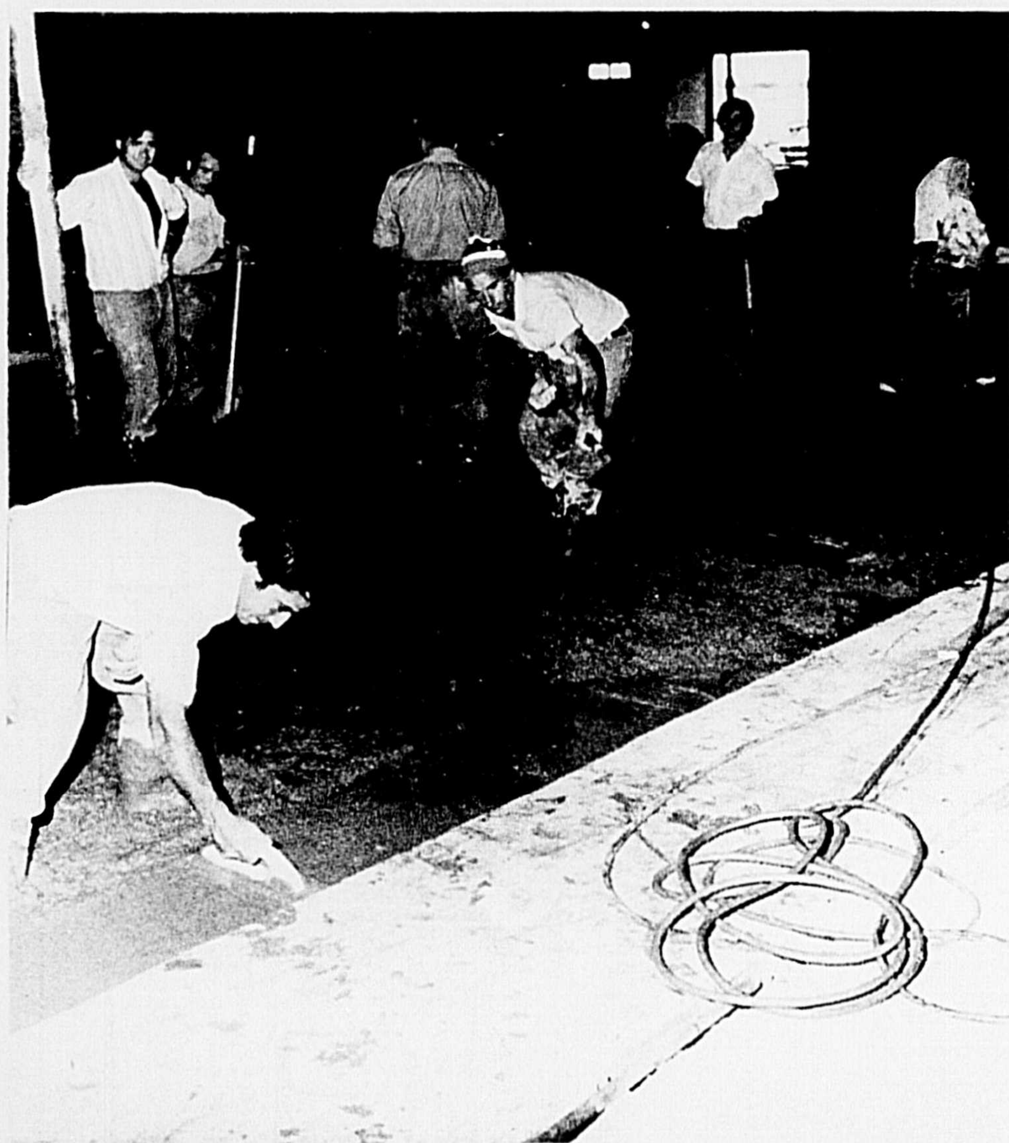
Pour des travaux de cette envergure, tout un équipement spécial était requis pour acheminer le ciment apporté par les bétonnières.
