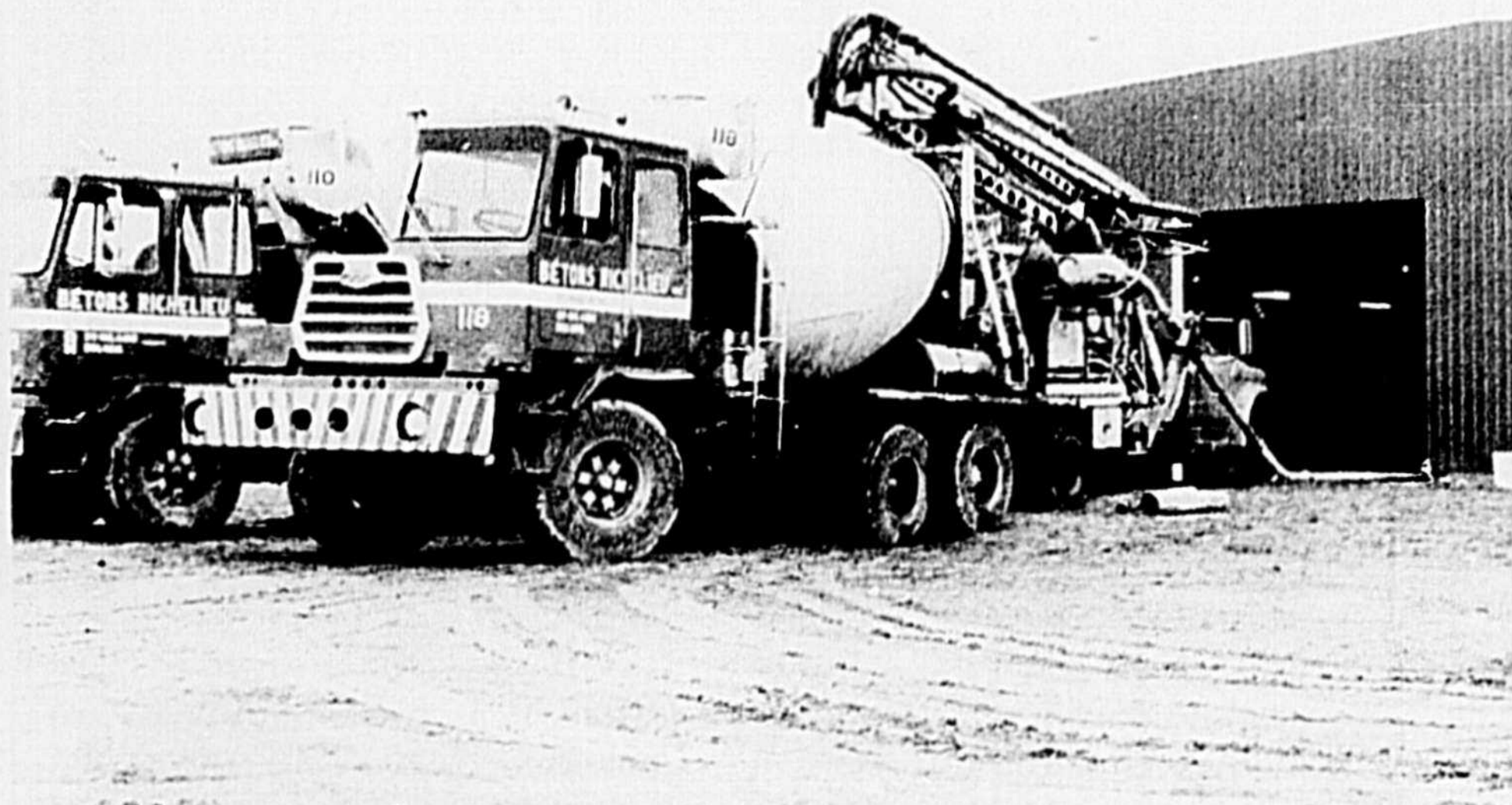
Les ouvriers s'affairaient, la semaine dernière, au coulage de la dalle en ciment qui recevra la glace artificielle.
