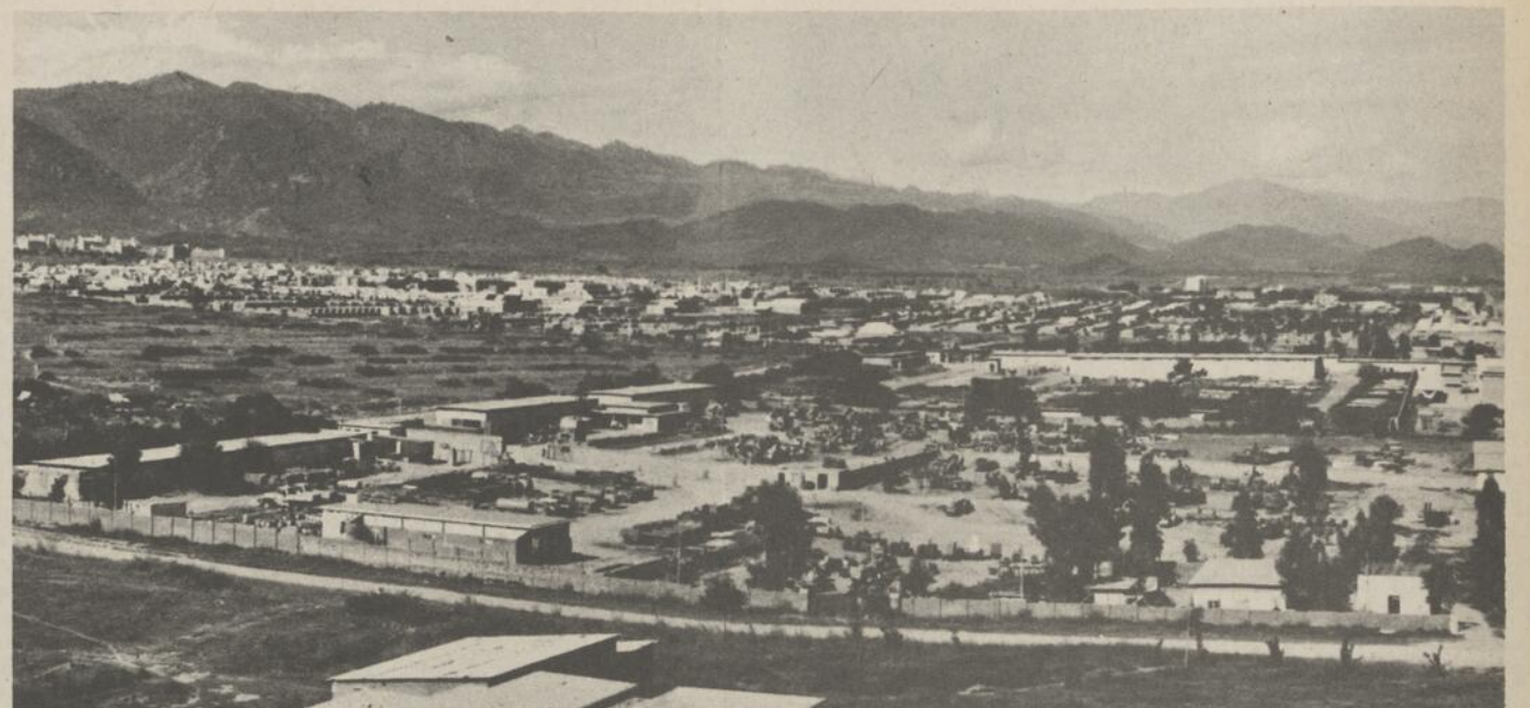
NOUVELLE CAPITALE --- Voici Islamabad, nouvelle capitale du Pakistan, sise à 10 milles de Rawalpindi. La petite ville, issue d'un rêve du président Ayoub Khan, n'existait pas il y a cinq ans. Les avenues y sont larges, propres
