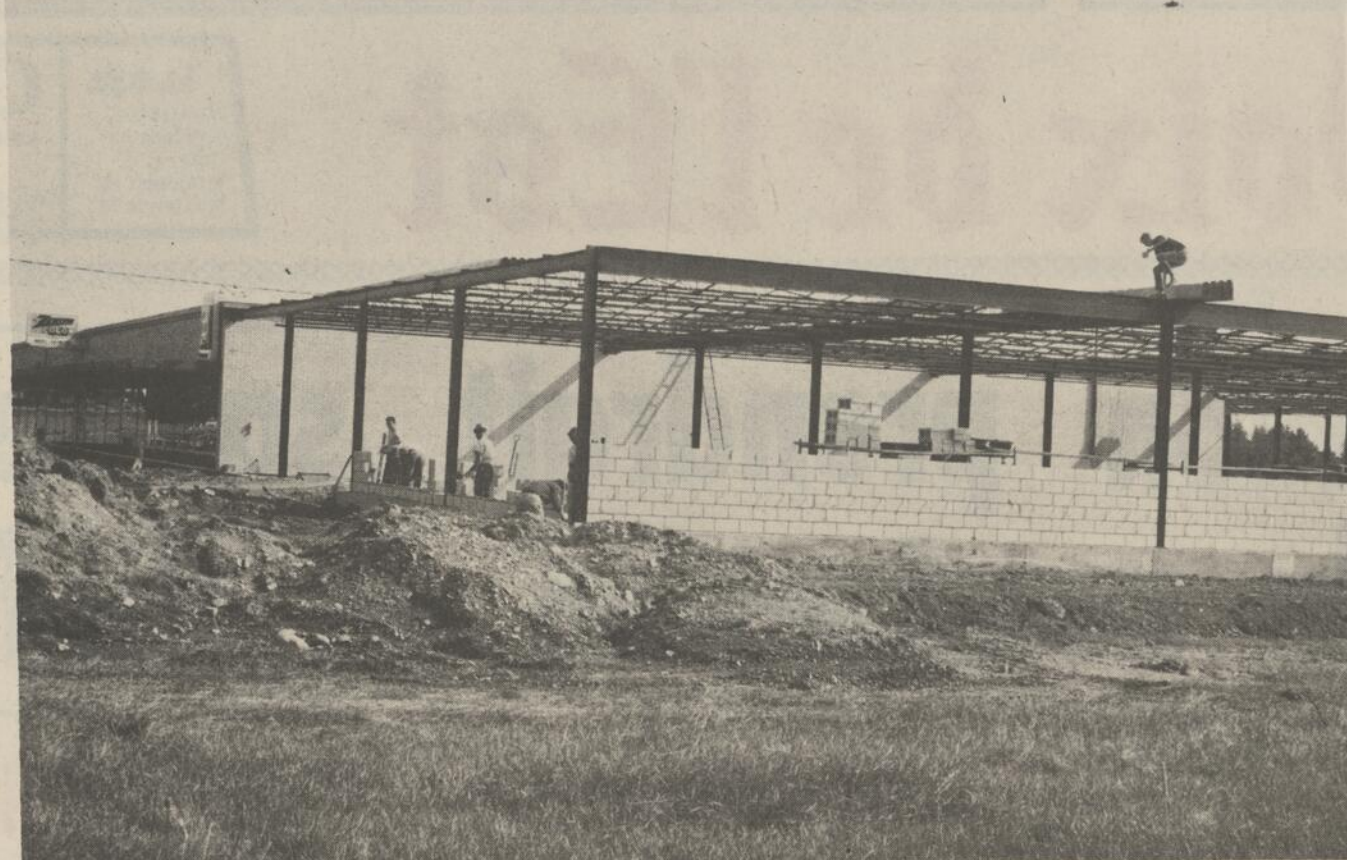
PROGRES RAPIDE - Les travaux d'agrandissement du magasin de meubles Harvey et Racine Inc. progressent rapidement. L'excavation de même que la structure d'acier ont été exécutés dans un temps record, de sorte que les deux propriétaires de l'établissement, MM. Laurent Forand et
