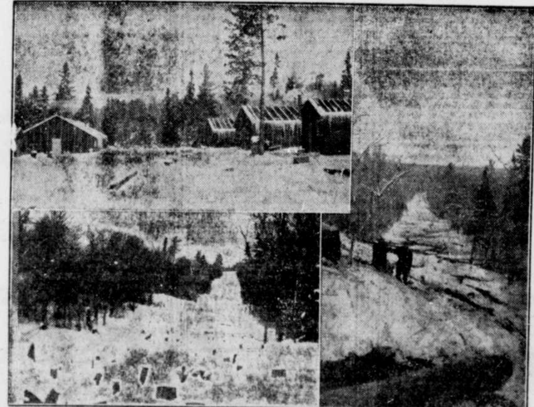
Ces photographies montrent une partie de la section de 17 milles de la route nationale North-Bay-Témiscamingue, (Ontario), de School House Corners aux environs de la rivière Jack. Elles donnent une idée des difficultés de construction d'une route moderne à travers la forêt vierge. En haut, à gauche, un camp de cantonniers. A droite et en bas à gauche, deux éclaircies à travers la forêt. Les travaux ont été entrepris au début de janvier et ils doivent être terminés pour le 30 septembre. Il faudra 300 hommes et un outillage moderne pour que les travaux soient terminés à la date stipulée dans le contrat.
