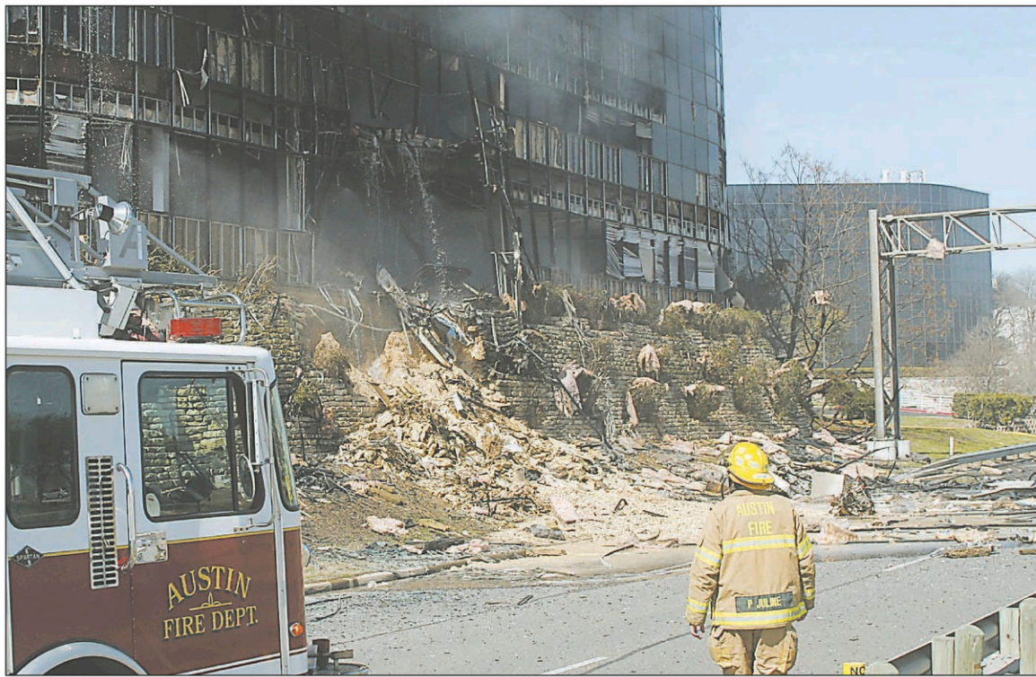
Un pompier constate les dégâts après qu'un petit avion privé se soit écrasé sur un édifice au Texas, hier.
