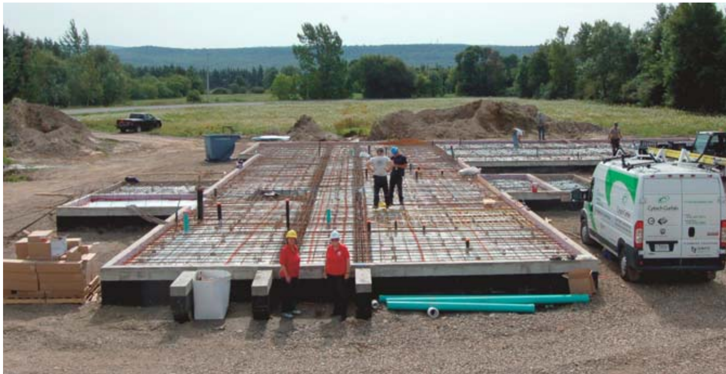
Avis aux sceptiques, la Maison d'Hélène prend bel et bien forme, comme le démontre cette photo où l'on aperçoit le solage. Confiés à la firme Construction André Deschênes de Montmagny, les travaux ont débuté le 26 avril et la première pelletée de terre a eu lieu 30 mai. Arrivera bientôt le structure préparée par Maisons Laprise.
