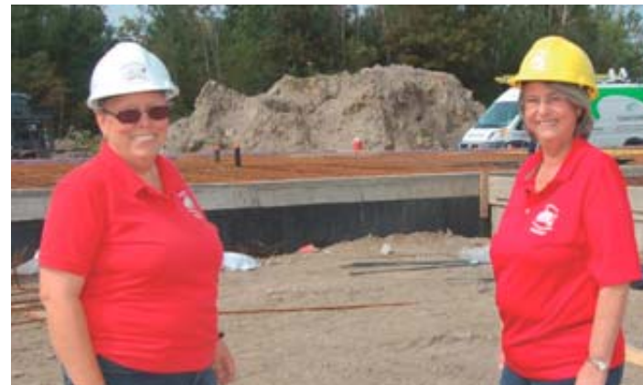
Mmes Hélène Caron et Lise Vachon sur le chantier de construction de la Maison d'Hélène.
