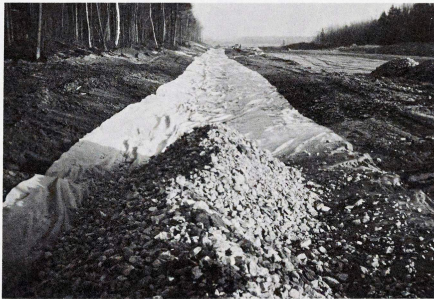
"Bidim" en place et chargement de pierre avant la mise en forme.
