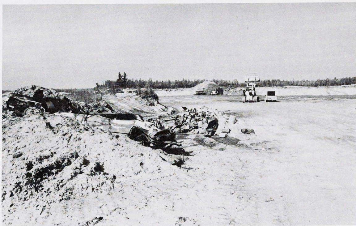
10- Comme les excavations non planifiées laissent des terrains dégradés, le dépotoir suit le bulldozer immédiatement et accélère ainsi la dégradation. (Bois-des-Filions).
