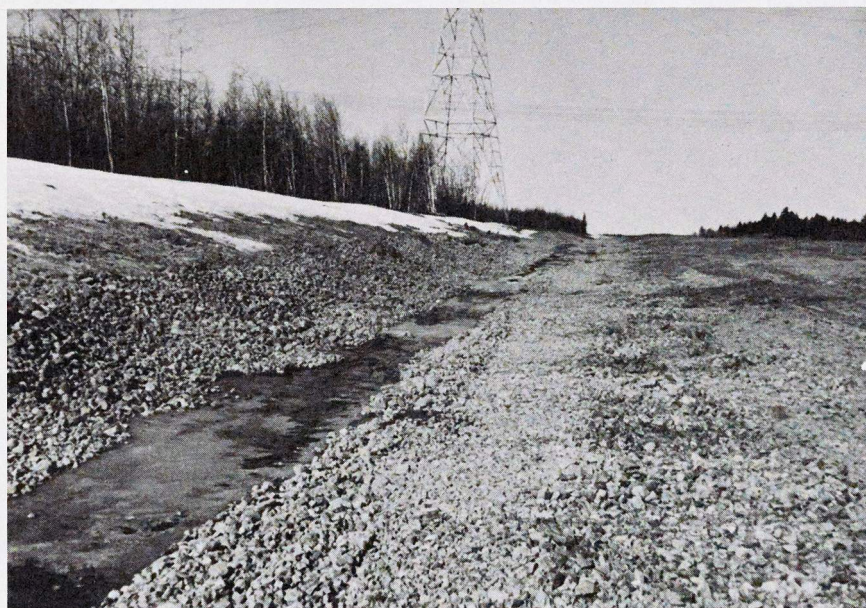
Aspect du fossé protégé avec "Bidim" et chargement de pierre.
