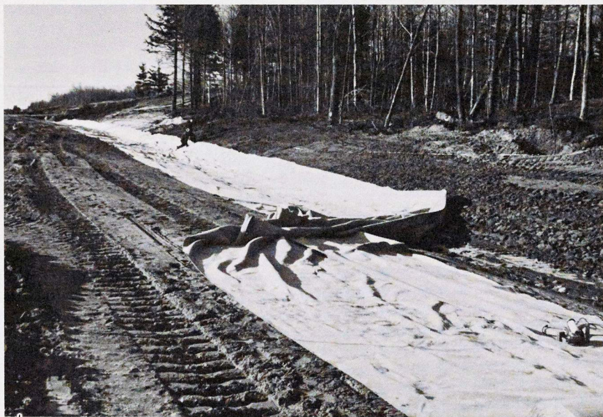
Mise en place du "Bidim"
