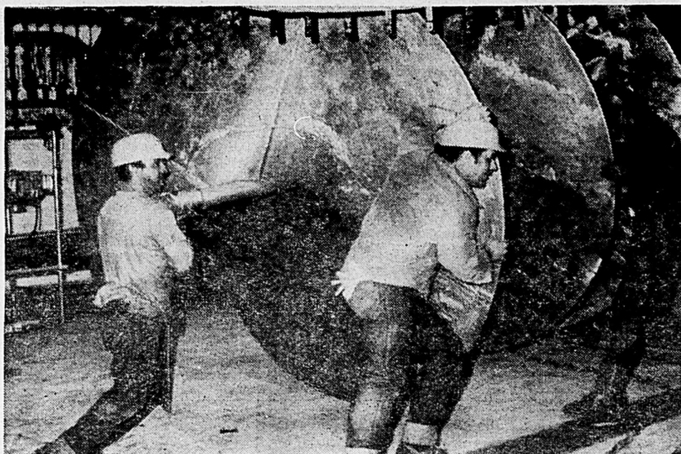
Durant la construction, les employés installent la vis sans-fin géante pour le refroidissement.
