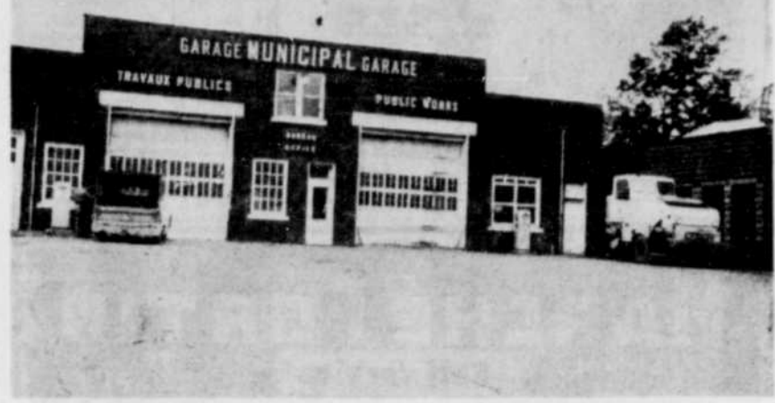
GARAGES MUNICIPAUX. — La cité de Granby possède actuellement des garages municipaux situés à l'arrière de l'hôtel de ville et qui sont devenus nettement inadéquats. On voit ci-haut, l'extérieur de l'un des garages que possède la cité et qui devraient, selon le conseil municipal, faire place à de nouvelles constructions dans un autre secteur de la ville.
