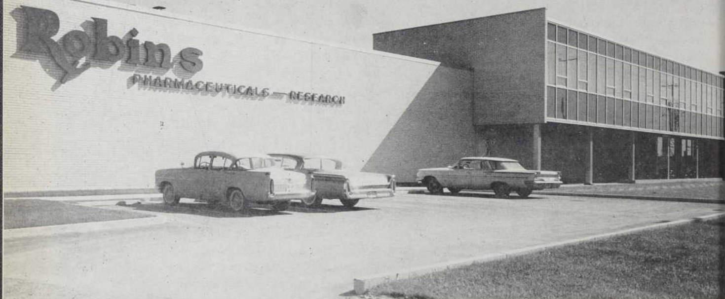
Façade de l'immeuble, vue de la Côte de Liesse.
