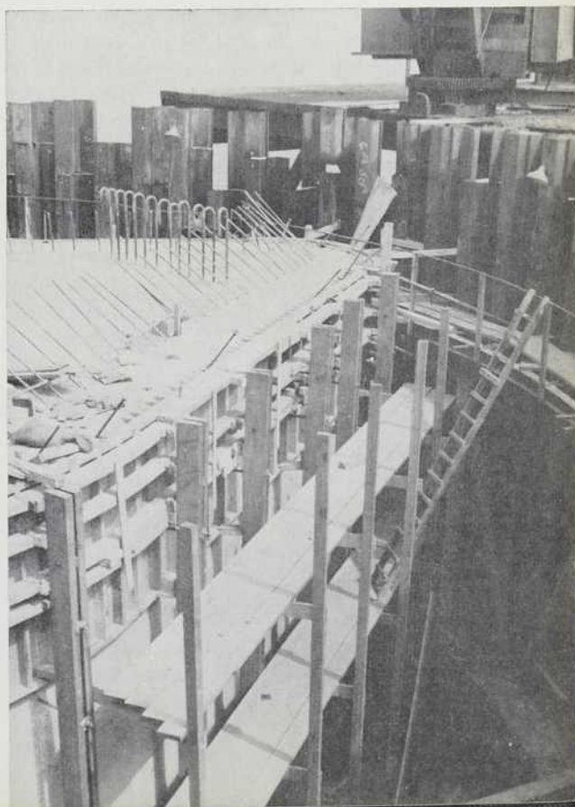
Travaux de fondations de l'une des tours.
