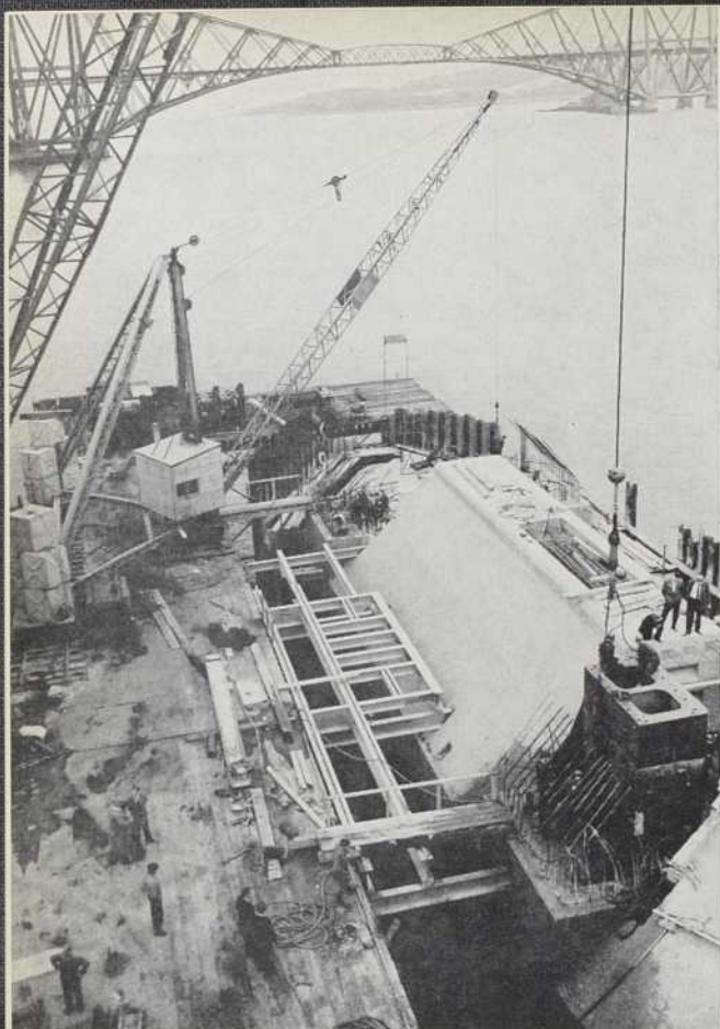
Pose de la 1ère section de 16 tonnes du pylone nord.
