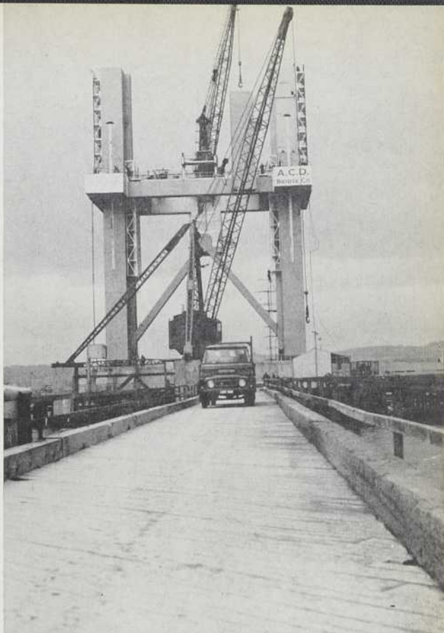
Mise en place d'une section de pylone d'acier.
