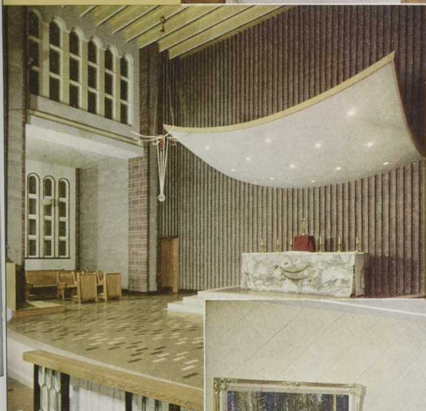
Les blocs de béton Haydite coloré ont été utilisés comme fini mural intérieur pour l'Ecole Supérieure St-Pie X, Montréal. Architecte: GÉRARD NOTEBAERT. Entrepreneur général: FERNAND J. LABROSSE INC. Manufacturier des blocs de béton: PRESSURE PIPE CO. LTD.
