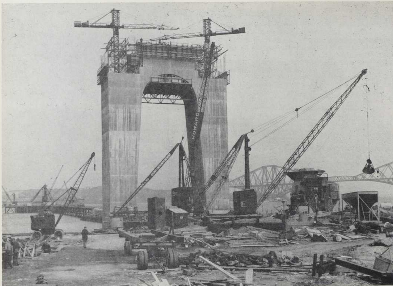
La tour secondaire sud, alors que la construction est presque achevée.
