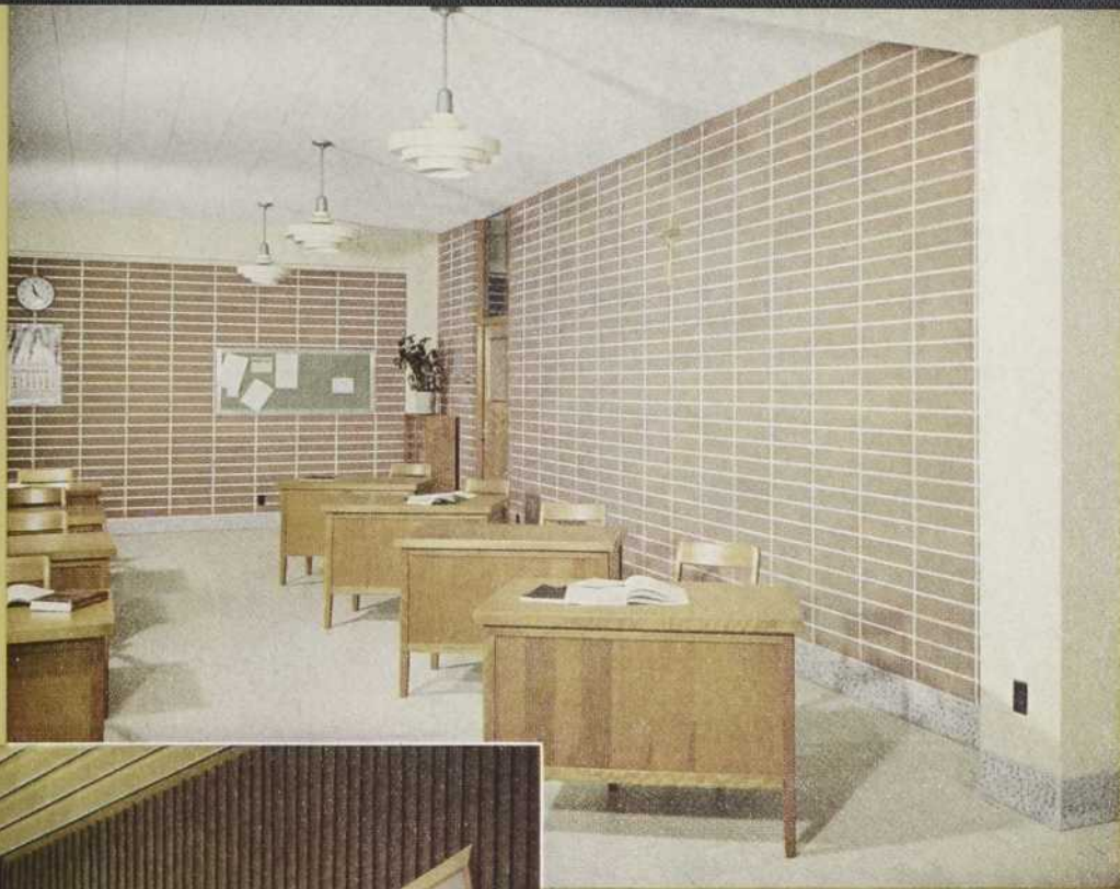
Les blocs de béton Haydite coloré ont été utilisés comme fini mural intérieur pour l'Ecole Supérieure St-Pie X, Montréal. Architecte: GÉRARD NOTEBAERT. Entrepreneur général: FERNAND J. LABROSSE INC. Manufacturier des blocs de béton: PRESSURE PIPE CO. LTD.
