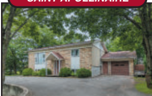
Duplex 24 x 36 construit en 1982, comprenant 2x4 1/2 pièces. Garage attaché, remise, terrain paysager de 20 290 pi 2 .
