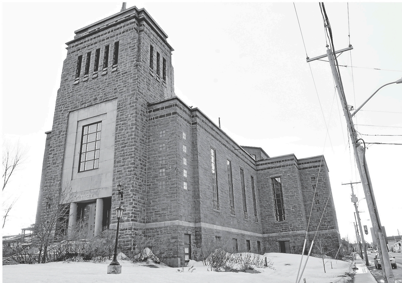
L'Église Sainte-Cécile, à Saguenay, fait partie de la cagnotte des biens non réclamés de Revenu Québec. Elle a fait l'objet d'une bataille juridique entre l'ancien propriétaire, André Reid, et le ministère du Revenu, et devrait éventuellement être démolie. — PHOTO LE QUOTIDIEN, ROCKET LAVOIE
