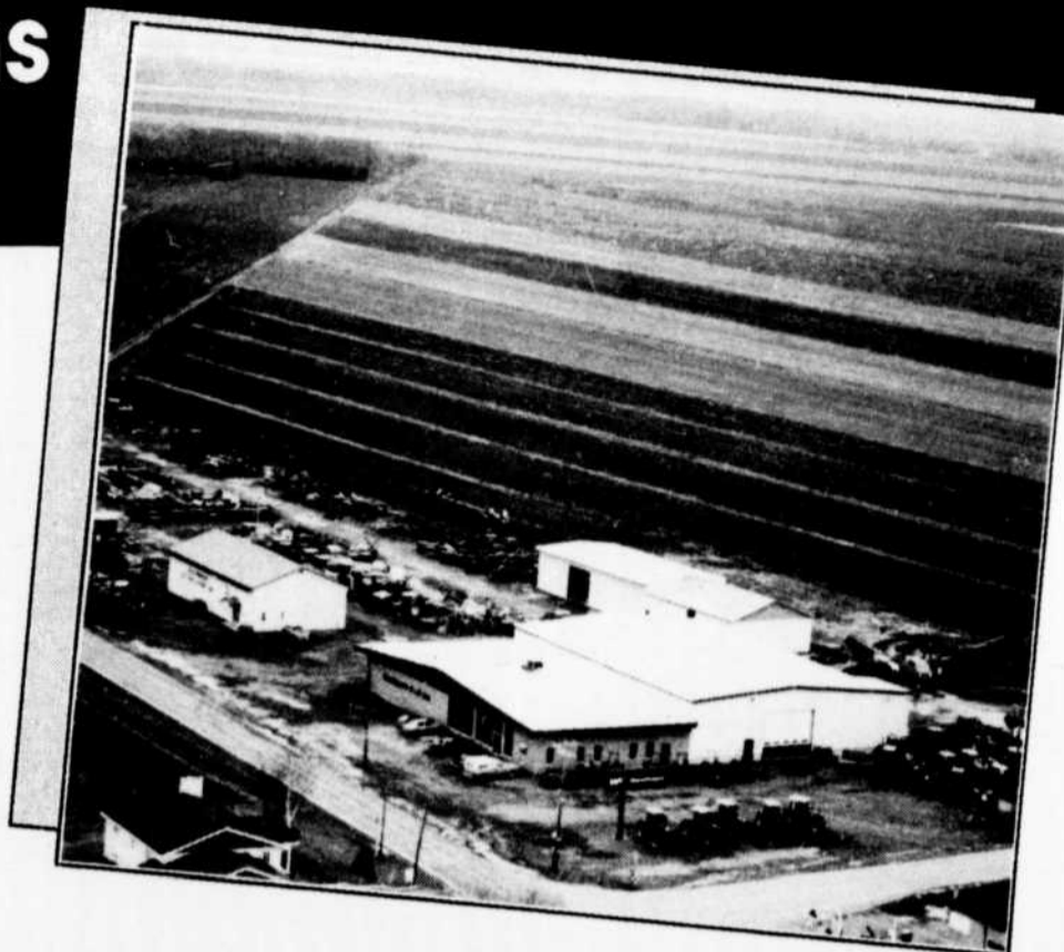
Les installations actuelles de Machinerie C. & H. à St-Guillemme.
