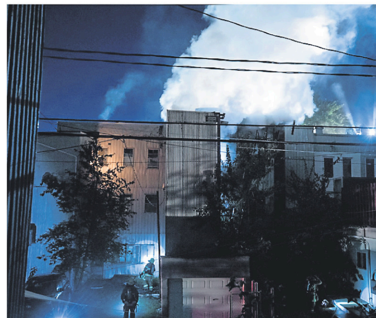
Les flammes se sont propagées au toit de l'immeuble à logements de trois étages. — PHOTO COLLABORATION SPÉCIALE STEVE JOLICOEUR
