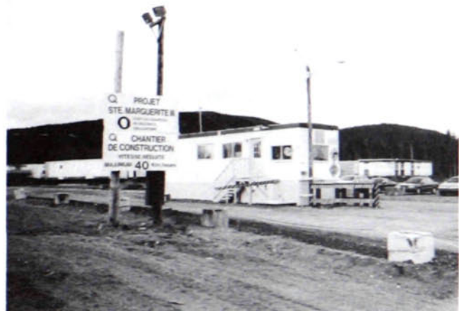
L'entrée du chantier SM-3, à une centaine de kilomètres de Sept-Îles.
