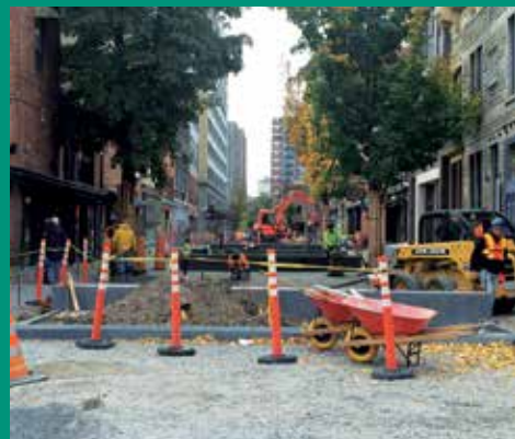
Les travaux de l'automne dernier comprenaient le pavage, l'installation de bancs et la construction de fosses de plantation.
