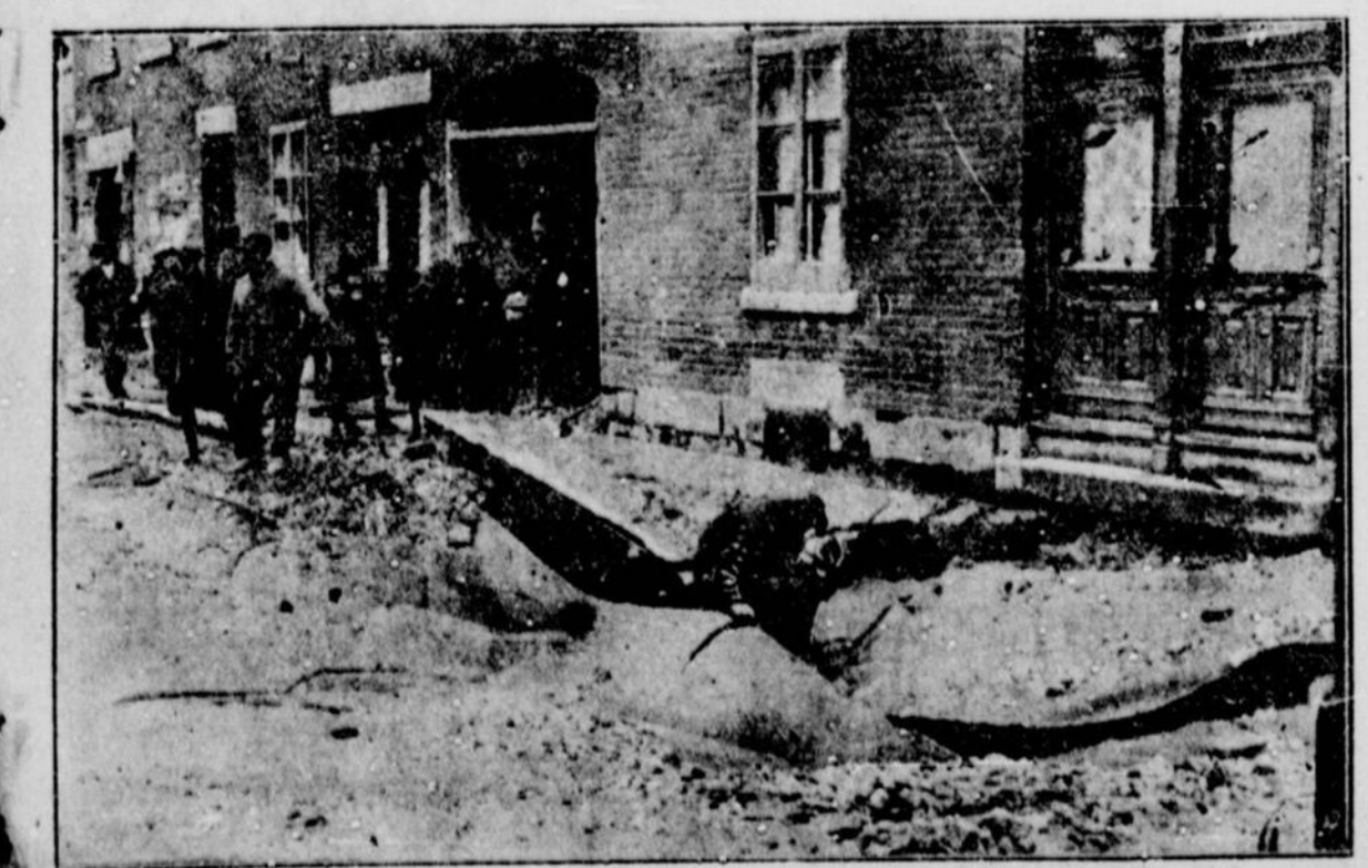
Les dégâts causés par l'explosion d'une conduite d'eau, ce matin, rue Demontigny Est, près Hôtel de Ville. Le trottoir de pierre a été éjecté et l'eau sortant par cet immense orifice a envahi les caves des maisons environnantes.
