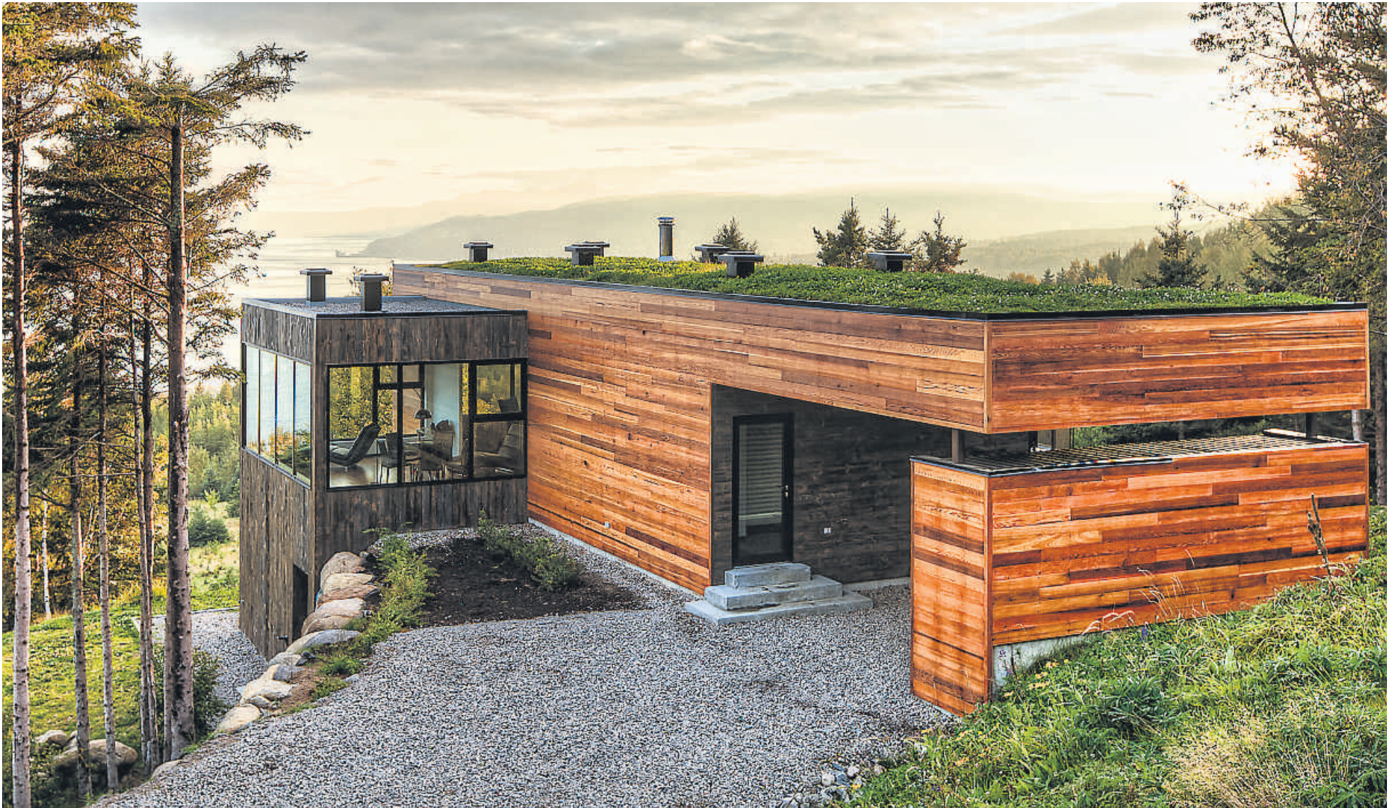
La résidence Malbaie V, dite «Le Phare», est constituée d'un volume principal qui s'élançe et se projette vers le fleuve, et d'un second volume perpendiculaire sur lequel il s'enracine solidement. Son toit est végétal.
