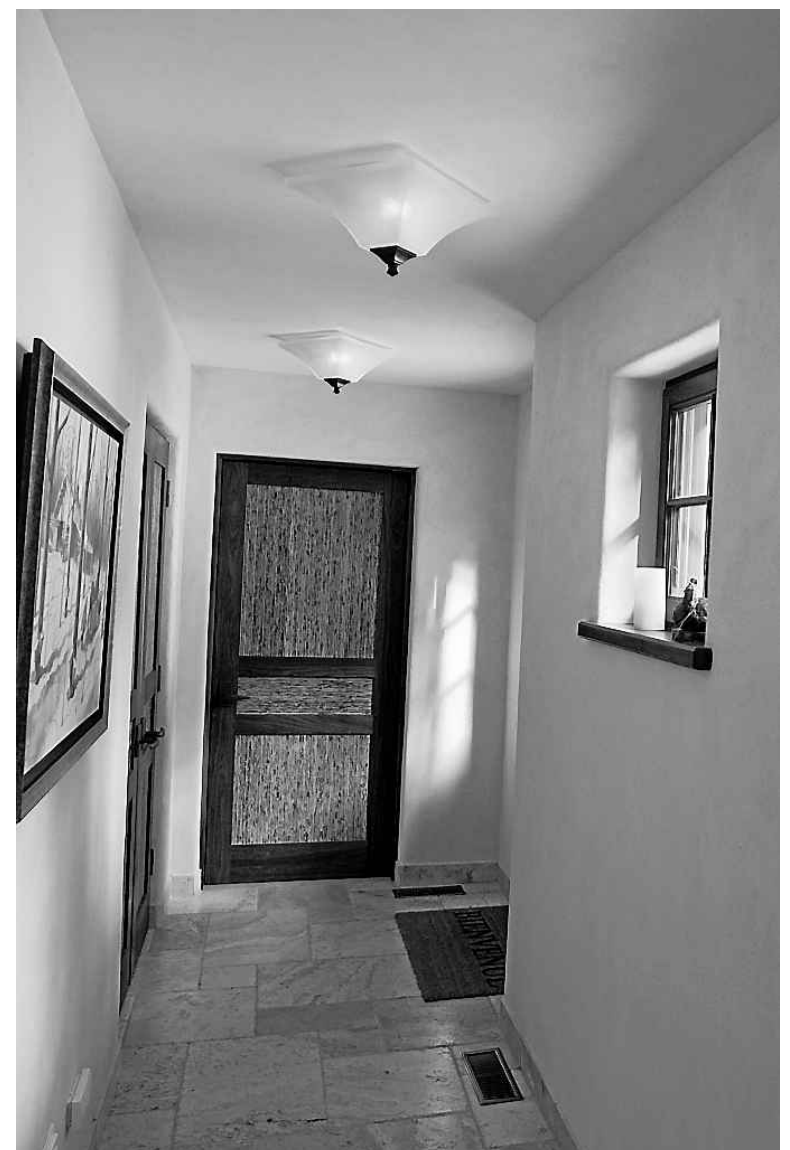
L'enduit de chaux additionné de chanvre améliore l'acoustique: les sons rebondissent moins, deviennent plus doux. — PHOTO LA PRESSE, ALAIN ROBERGE
