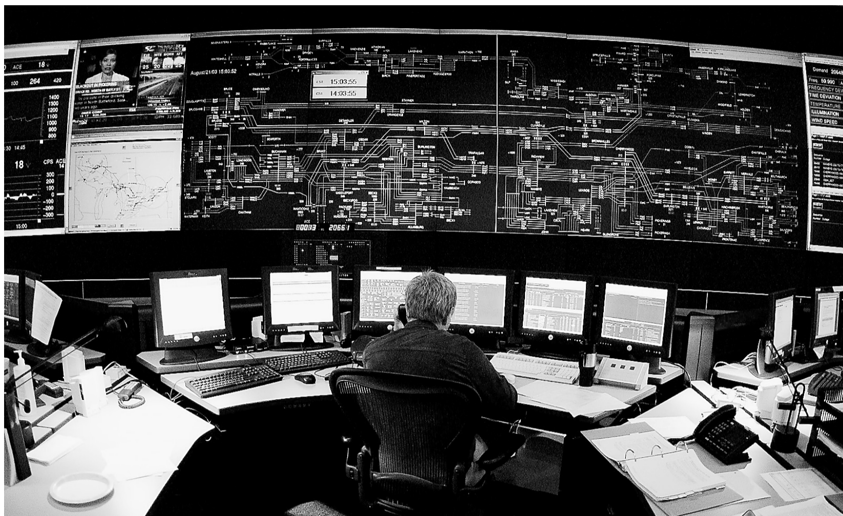
Un employé surveille une partie du réseau de distribution d'électricité en Ontario.
