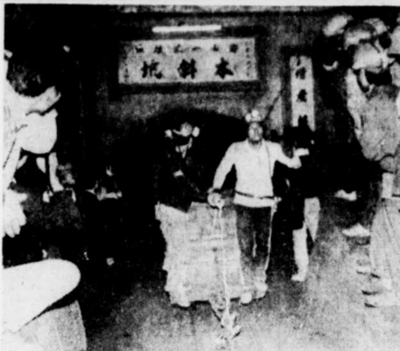
Huit heures après l'explosion, les secouristes n'avaient pu remonter à la surface qu'un seul survivant, trouvé inanimé et gravement blessé.
