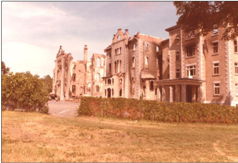
Collège Jésus-Marie de Sillery après l'incendie de 1983. C'est en septembre 1984 que la nouvelle construction ouvrit de nouveau ses portes aux élèves. (Photo : sœur Cécile Kirouac, collection Céline Kirouac)
