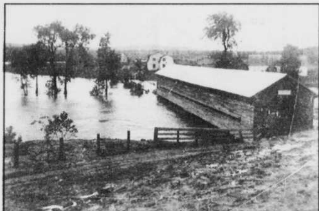
Le pont couvert de la rivière Batiscan est menacé par la crue des eaux, suite à un éboulis au Bloc B. C'était en octobre 1924.
