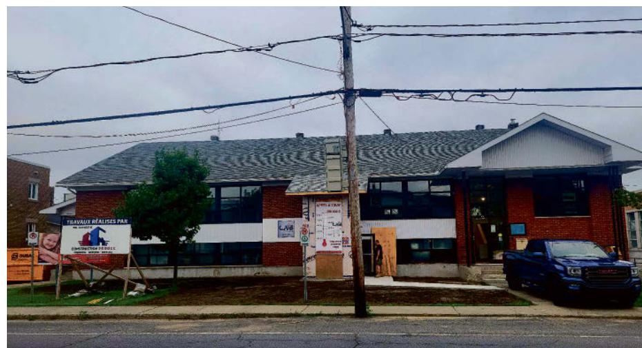
Les locaux du 70, rue Élizabeth sont sur le point d'être inaugurés après les travaux qui se termineront sous peu. Photo gracieuseté
