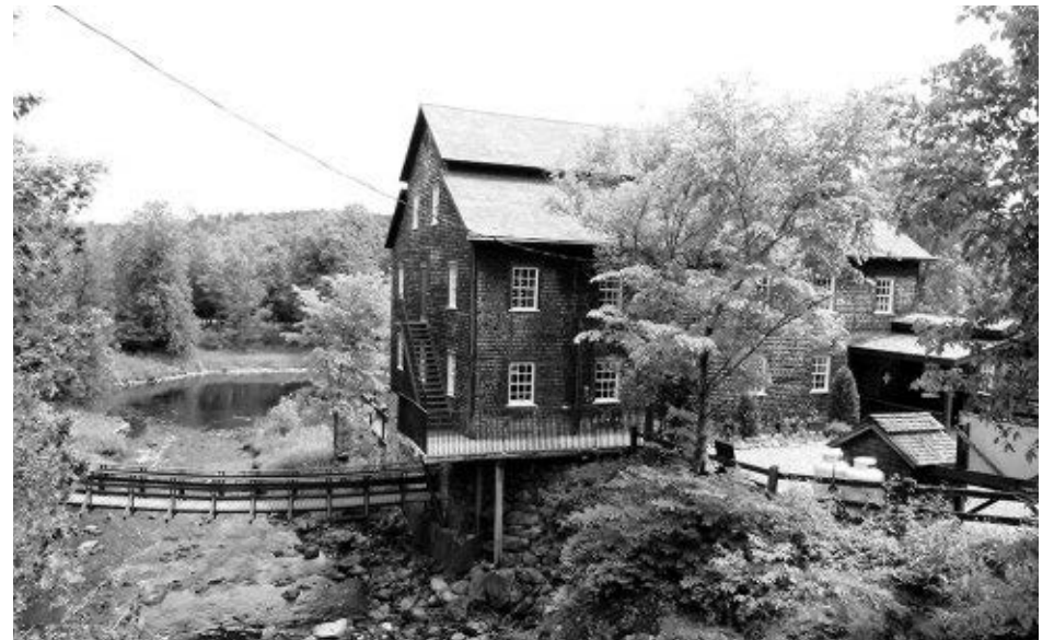
Moulin à laine d'Ulverton.
